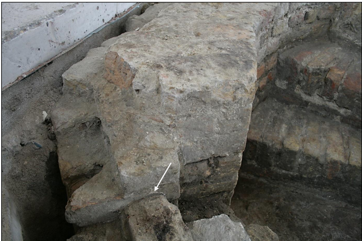
Figuur 71 Detail van de afwerkingslaag op de dagkant van de deuropening
