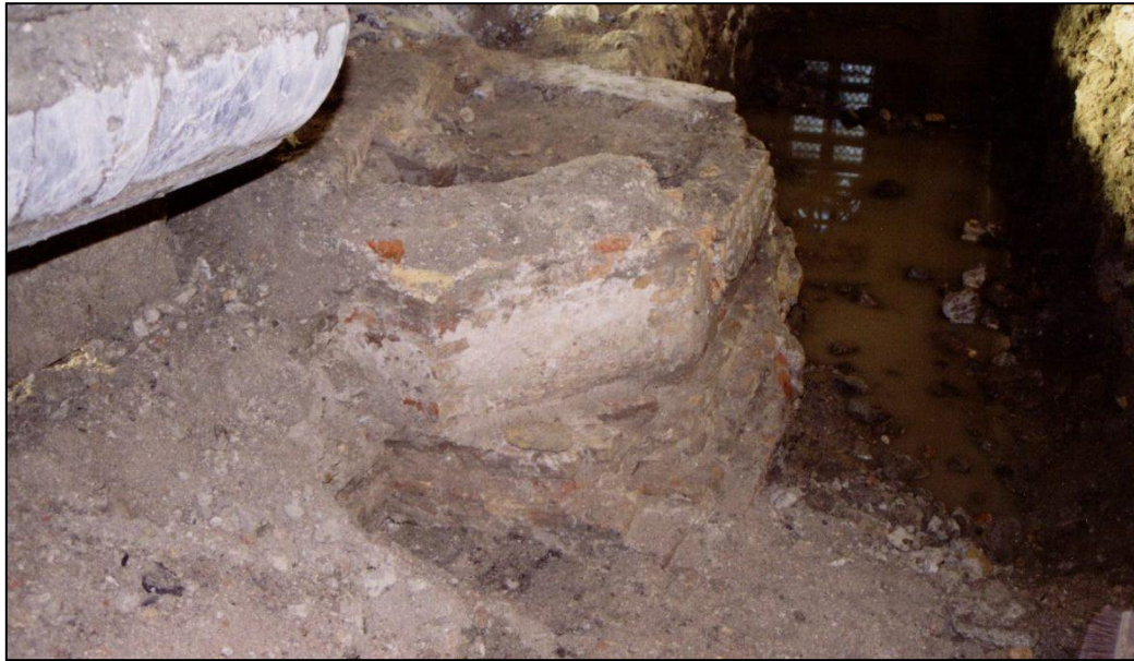
Figuur 64 De traptoren kwam aan het licht tijdens de graafwerken in de benedenkerk (Lic. O. Snauwaert)
