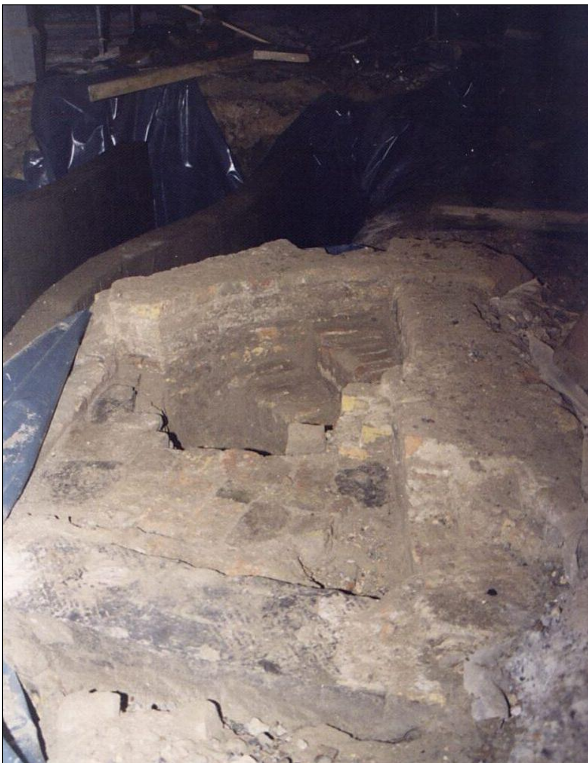
Figuur 66 De traptoren tijdens de aanleg van het terugnamekanaal (Lic. O. Snauwaert)
