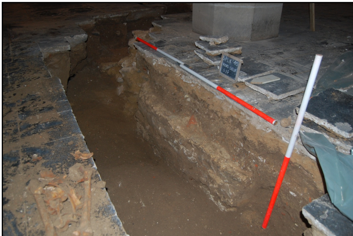
Figuur 22: S37 in sleuf Noord: natuurstenen massief/muur bedekt met witte kalkmortel.
