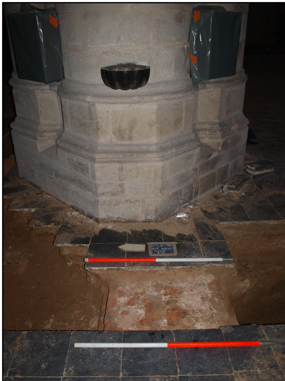
Figuur 30: S14: fragment van een bakstenen funderings- of kettingmuur ten westen van de massieve NW zuil.
