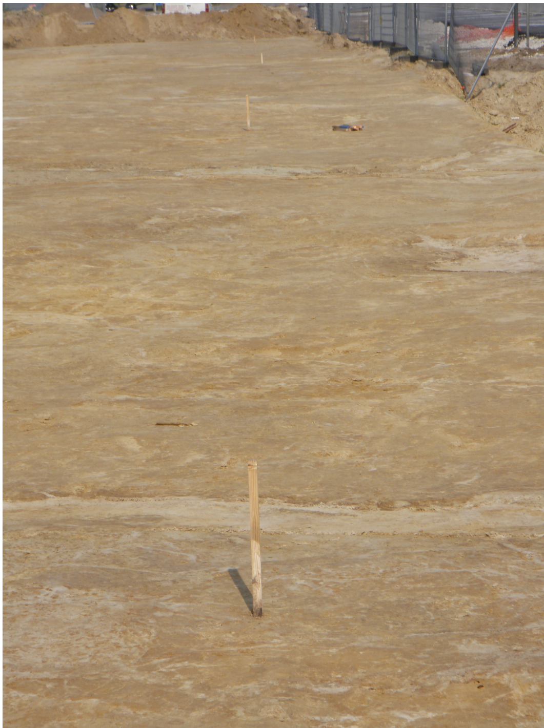
Afbeelding 4: Overzichtfoto van de uitgezette piketten volgens het aangeleverde plan van het archeologisch vooronderzoek.
