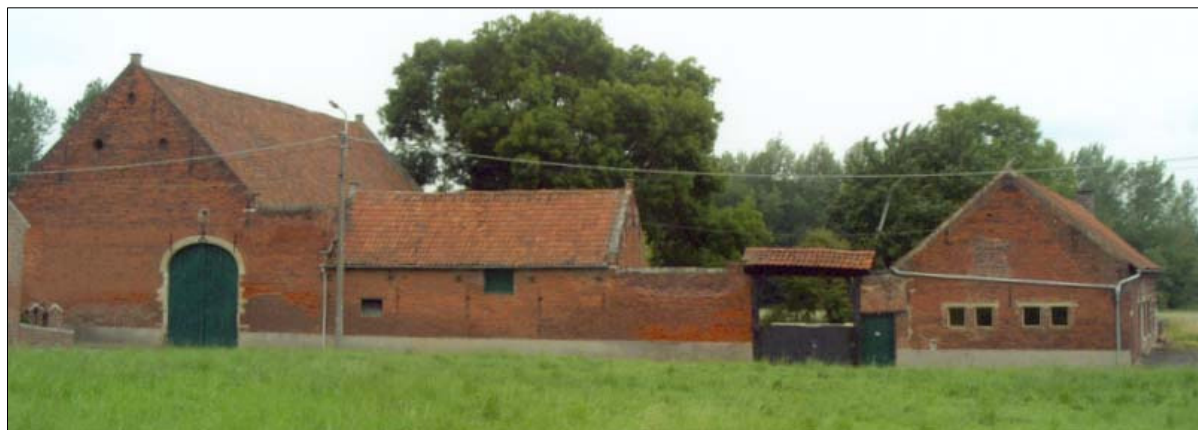
Fig. 5: Zicht op het 'Pachthof van de Zeven Slapers' aan de straatzijde (Bron: Jos Verhoogen - Erfgoedhuis Kortenbergh)
