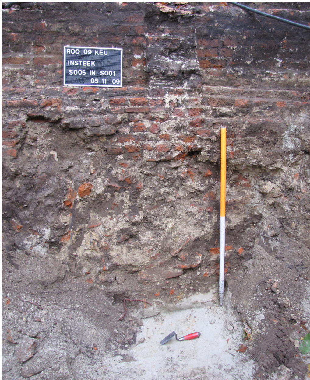
Afb. 22: funderingsopbouw van de westelijke muur, met de (ondertussen weggebroken) tussenmuur.
