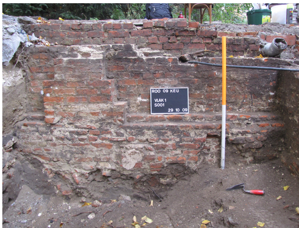
Afb. 23: steunbeertje aan de binnenzijde van de westelijke muur.
