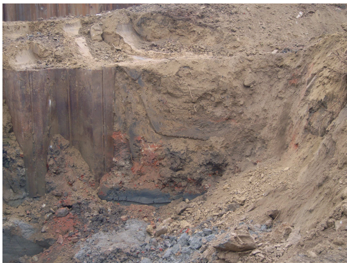
Figuur 7. Bodemprofiel tijdens het uitgraven van het omleggingstracé.
