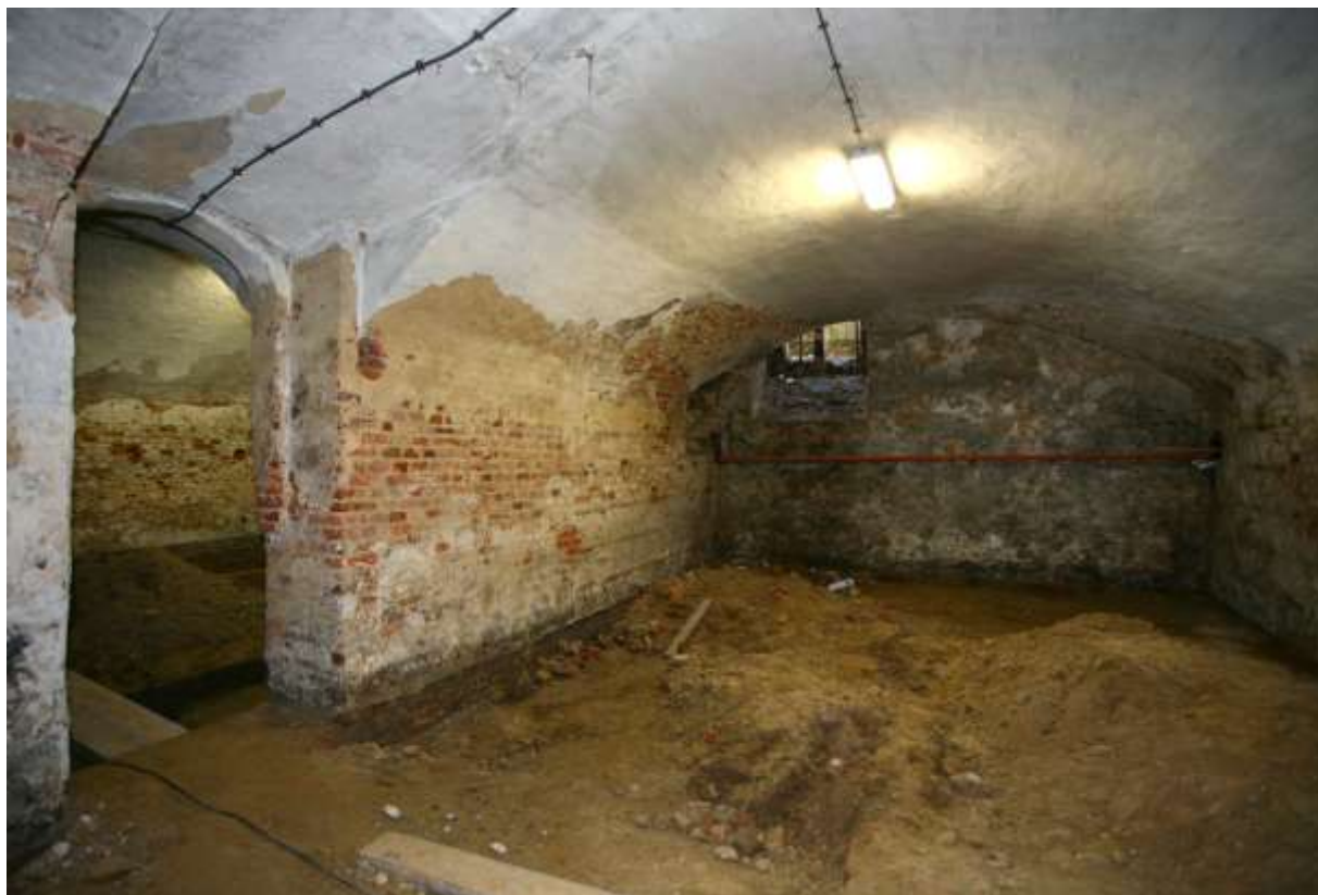
Fig. 37 De derde noordelijke kelder, gezien naar het westen.
