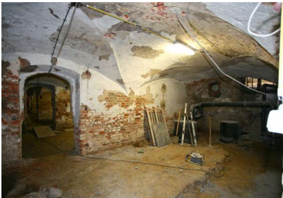
Fig. 38 De eerste noordelijke kelder, gezien naar het westen.
