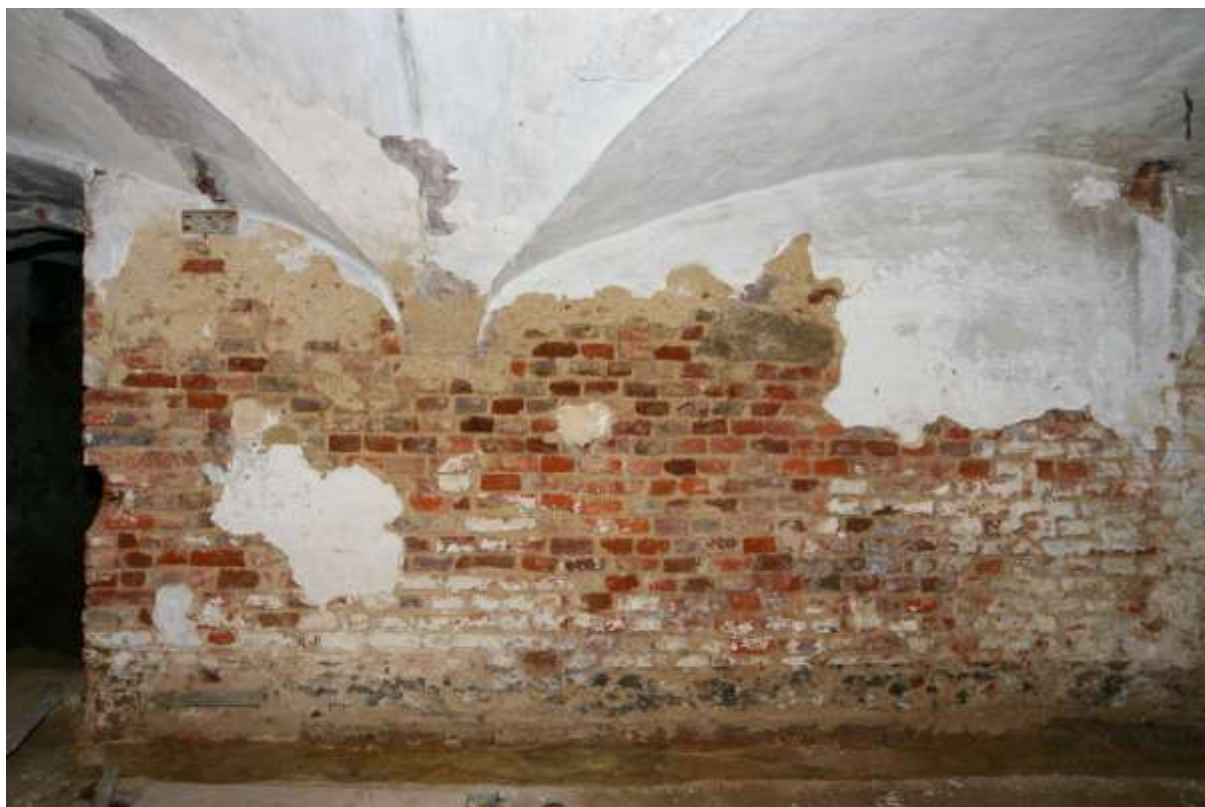
Fig. 40 Zuidmuur van de tweede noordelijke kelder, met bakstenen in een onregelmatig, vooral kops verband. Centraal bovenaan in de muur steekt een stuk natuursteen (Lediaanse kalkzandsteen?).
