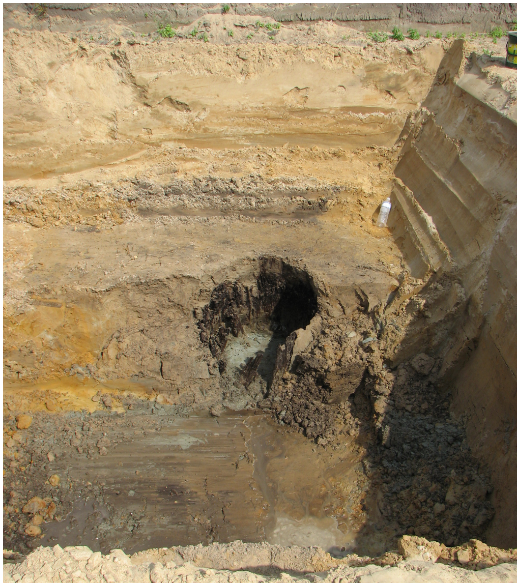
Afb.17 zicht op bekisting van waterput S004
