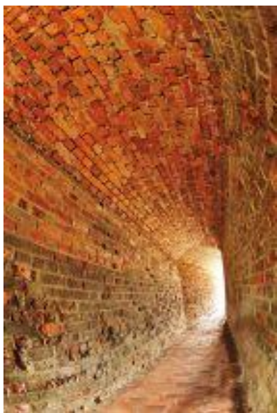
Fig. 5 Overdekte bakstenen gang zoals aangetroffen op het domein te Raversijde.
