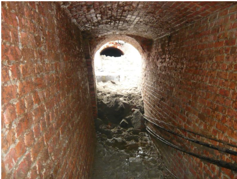
Fig. 2 Zicht vanuit de zuidwestelijke gang met het door de rioleringsput vernielde stuk en de niet toegankelijke gang richting noordoosten.
