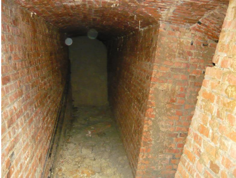
Fig. 1 Zuidwestgang met puin onderin en afsplitsing richting noordwesten.
