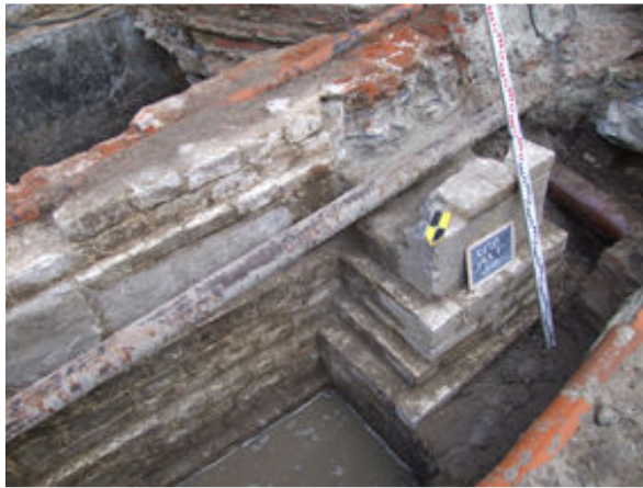
Fig. 3: Zicht op de steunbeer met witstenen parement (Stad Gent, Dienst Stadsarcheologie)
