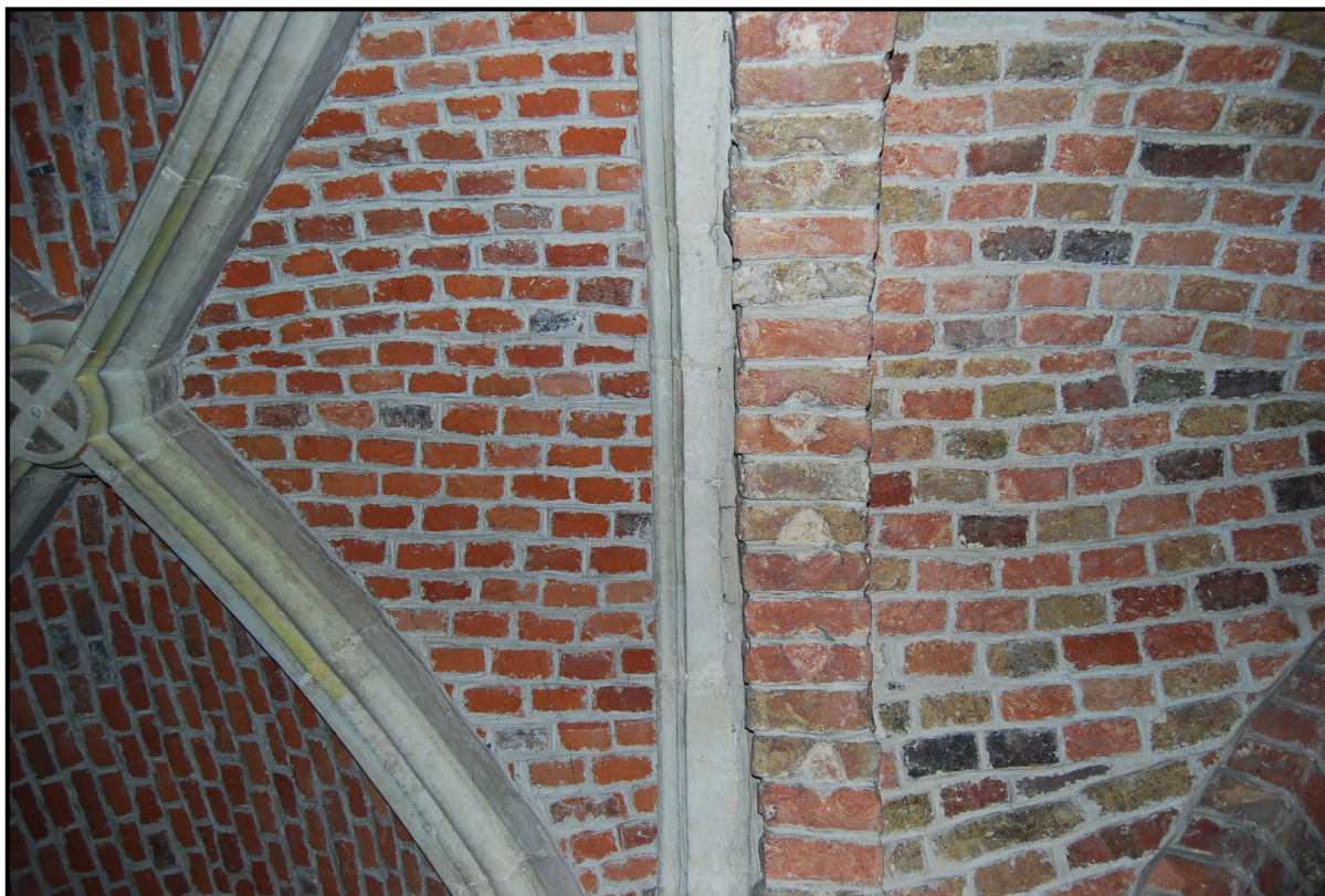
Figuur 20: Duidelijk verschil in bouwstijl en bakstenen in de crypte tussen zone 1 en 2 (16 de -eeuws, gotisch = links) en zone 3 (13 de -eeuws, romaans = rechts).
