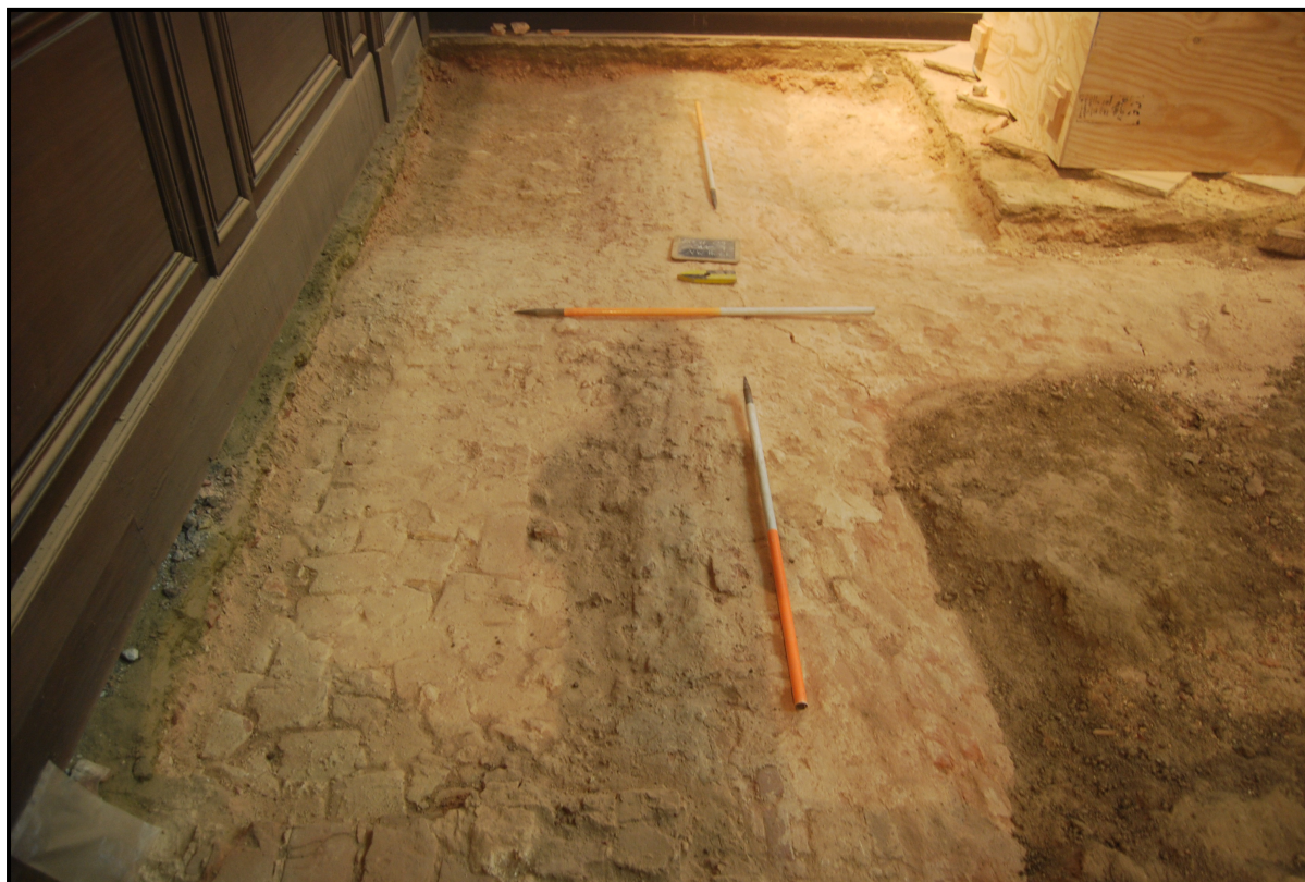
Figuur 7: Zicht op de noordoostelijke hoek van zone 1, met de hoger gelegen bolle gewelfoverbruggingen S5, S8, S9, S10 en S16.
