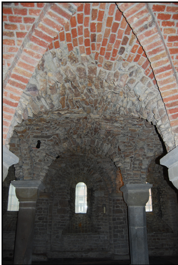
Figuur 28 (links): Zicht van in de crypte op de grens tussen het 11 de -eeuwse natuurstenen gewelf en het 13 de -eeuwse bakstenen gewelf.
