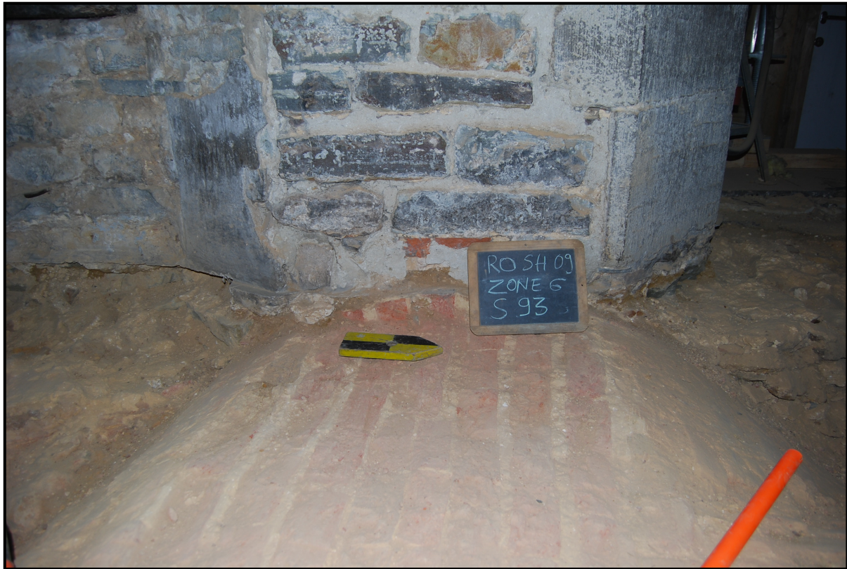
Figuur 30: S93 in zone 6, er is duidelijk ca. 10cm van het bakstenen gewelf gekapt.
