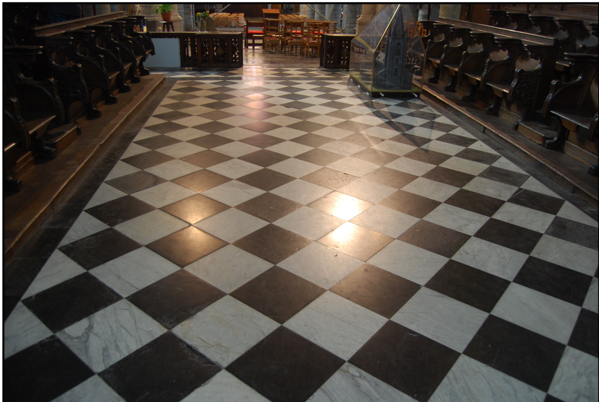
Figuur 16: Zwart-witte vloer in dambordpatroon, vermoedelijk daterend uit het begin van de 19 de eeuw.
