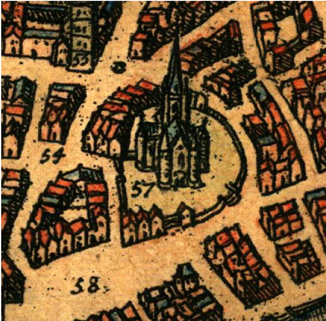
afb. 9: Detail uit het plan van Braun en Hogenberg, 1575, met op de voorgrond de latere huizen tegen de kerkhofmuur van de Sint-Niklaaskerk (Stad Gent, Stadsarchief)
