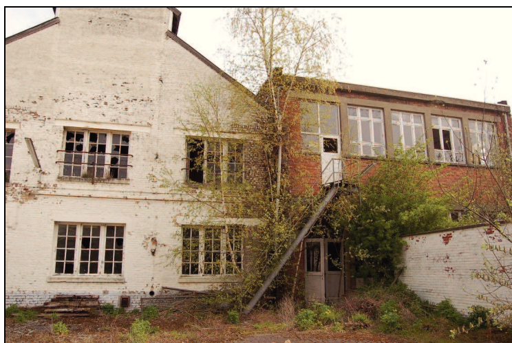
FIG. 5 Achterzijde van de bestaande gebouwen voor de afbraak.
