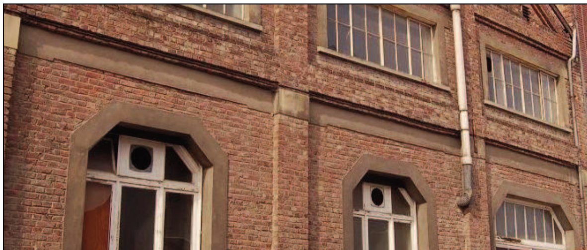
FIG. 15 Detail van de ramen in pre-Deco stijl van het in 2008 afgebroken fabrieksgebouw en latere refter van het Koninklijk Atheneum van Tongeren.
