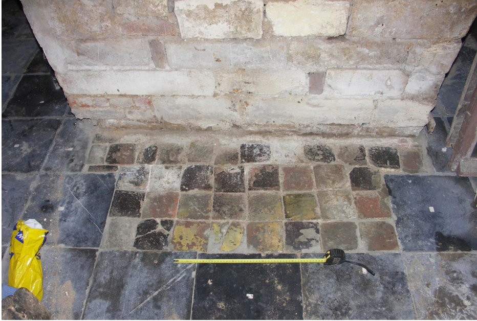
De vloer voor het altaar bestaat deels uit gerecupereerde tegels van 13 x 13 cm.
