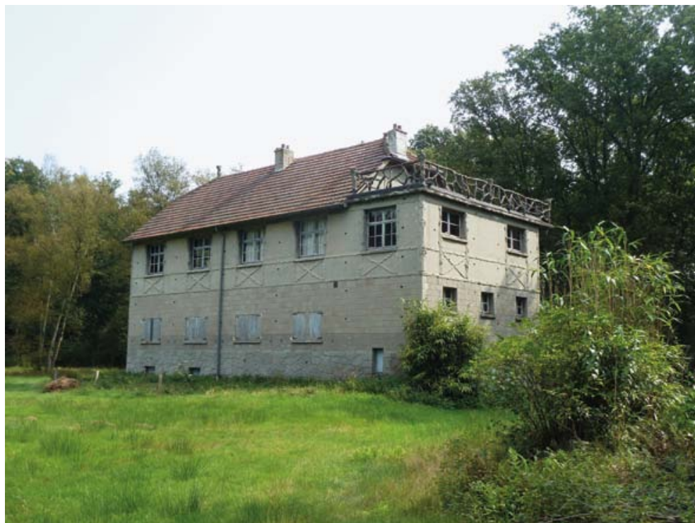
FIG. 113 Buitenverblijf in De Liereman (Oud-Turnhout). De gevels zijn volledig bekleed met cementrustiek (foto: Willem Hulstaert).
