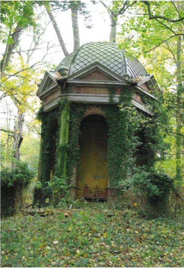
FIG. II4 Domein Couthof in Proven: het paviljoen is gebouwd bovenop een ijskelder.
