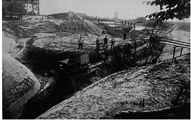
FIG. 2 Bij de aanleg van kasteel Allaert in Aalbeke werd een smalspoor met kiepwagentjes gebruikt ('Aalbeke in oude prentkaarten', Uitgave Davidsfonds Aalbeke, 1990, Zaltbommel NL).
