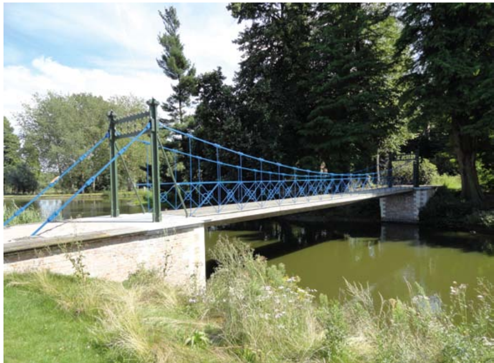
FIG. 106 Kasteeldomein Vilain XIII in Bazel: ijzeren hangbrug, ontworpen door J.B. Vifquain (1824).
