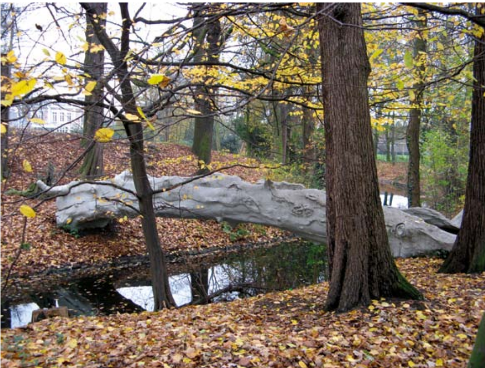
FIG. 108 Deze opmerkelijke brug (een imitatie-boomstam van gewapend beton) bevindt zich in het park van Lint. In de volksmond wordt ze 'De Kabouterbrug' genoemd (foto: Dirk Artois).
