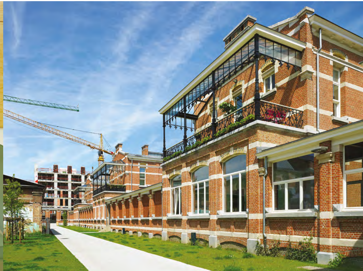
FIG. 7 Het voormalige Militair Hospitaal in Antwerpen is vandaag een aangename woonwijk midden in de stad.
