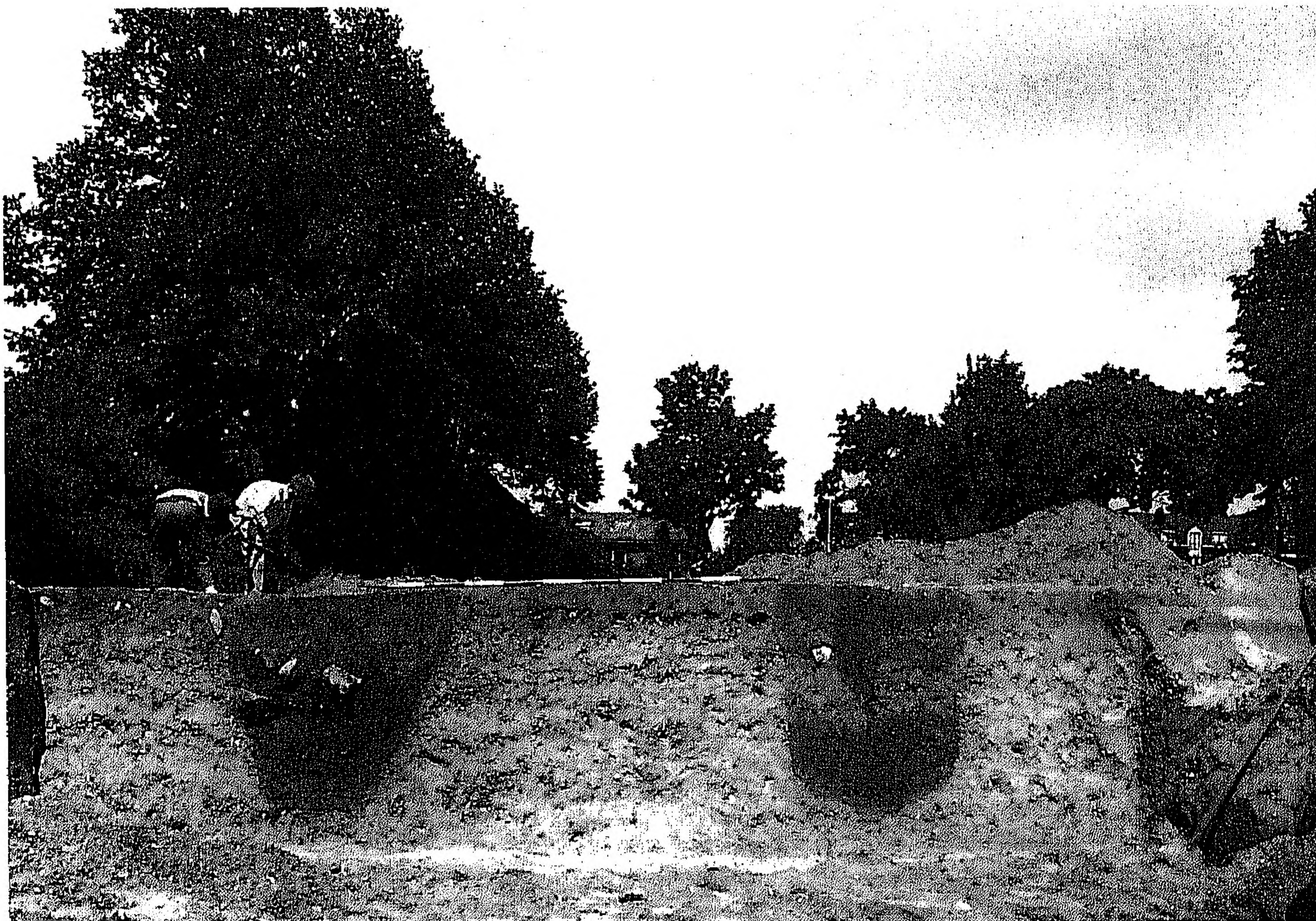
Afb. 3. Doorsnede door de twee zuidelijke paalkuilen van de Augusteïsche toren, afb. 1, 85, profiel A-B. In de rechter kuil is de verkleuring van de paal te zien. Opname vanuit het zuiden. Foto: R. Gras.
