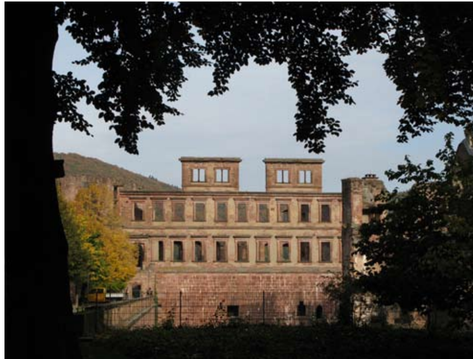
5.037 South facade to Englischer Bau, Heidelberg (1612-19)
