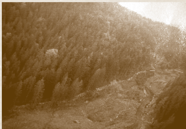
sl. 4 - Macesnikov plaz nad Solčavo je začel polzeti leta 1990 na mestu nekdanjega (fosilnega) plazua (foto: arhiv občine Solčava)
