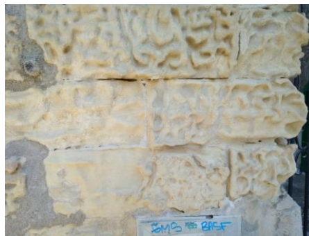
Figure 8. Alveolation pattern at the Church of Parroquia de la Mare de Déu dels Dolors, in Manacor (Majorca, Spain).
