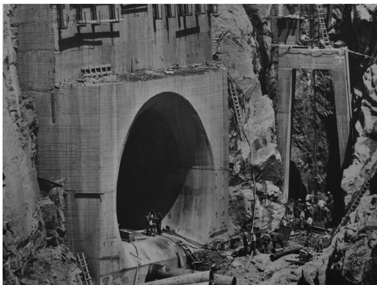
034 | Galeria de descarga - boca de entrada, pórtico de suspensão da comporta.
