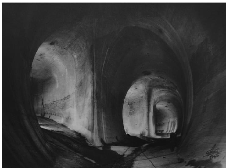
036 | Galerias de aspiração - entrada de água nas turbinas.
