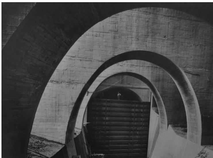
035 | Trampolim do descarregador de cheias - saída das águas turbinadas
