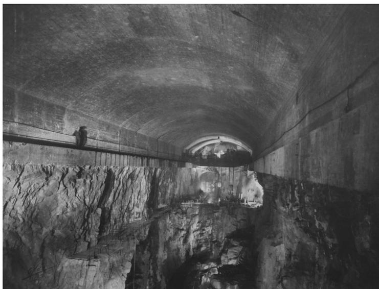
032 | Construção da abóboda da Central de Turbinas.
