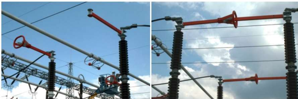
Figura 8 - Exemplo de um seccionador horizontal na posição de aberto (à esquerda) e fechado (à direita)
