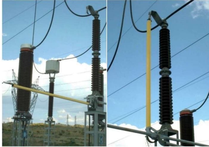
Figura 9 - Exemplo de um seccionador de terra na posição de aberto (à esquerda) e na posição de fechado (à direita)
