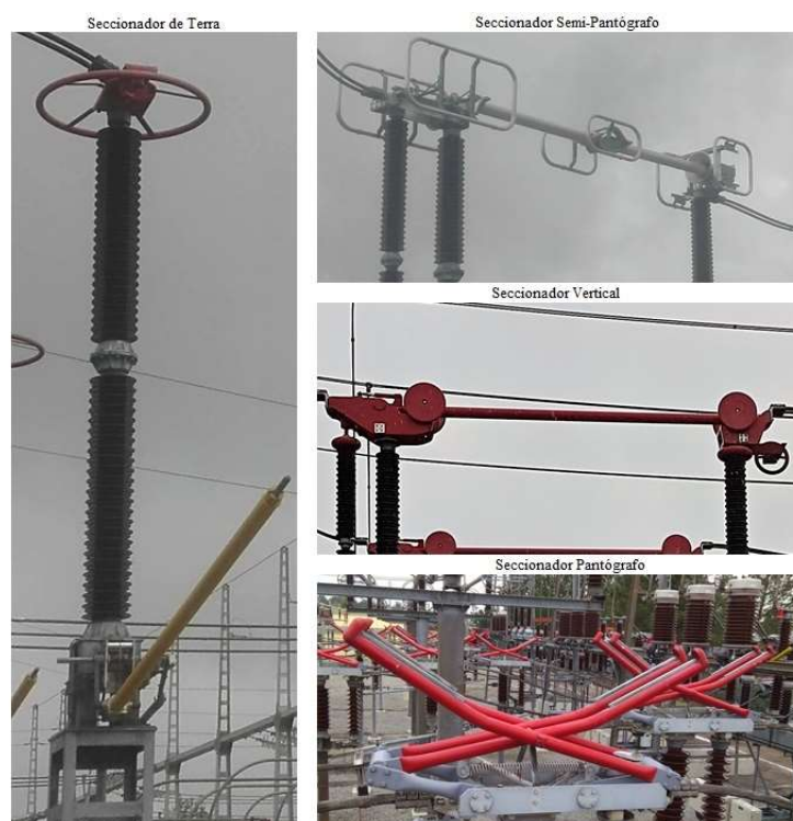
Figura 14 - Componente ativa de diversas tipologias de seccionadores
