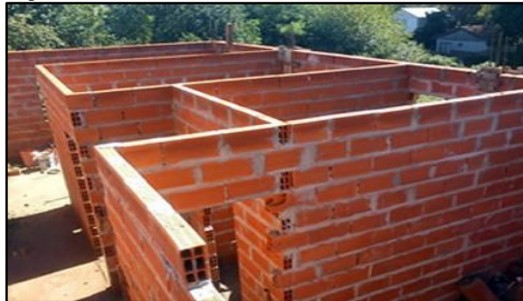
Figura 26. Muros de ladrillo hueco.
