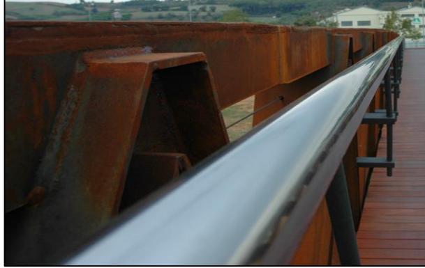
Figura 7. Puente con acero corten.
