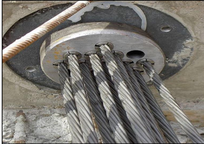
Figura 45. Concreto preesforzado, postensado.
