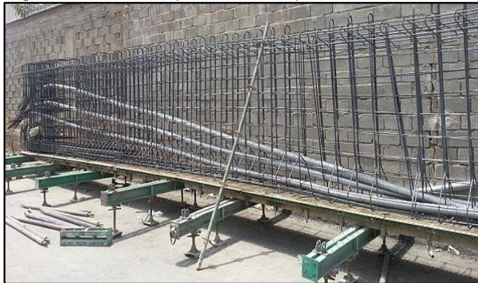
Figura 44. Concreto preesforzado, pretensado.
