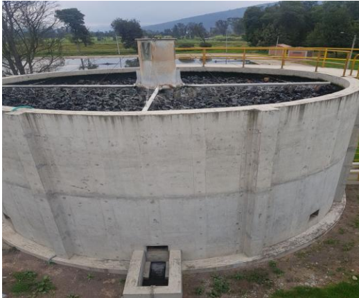
Ilustración 14 Perfil filtro percolador
