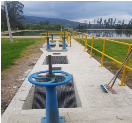
Ilustración 6 Rejillas
