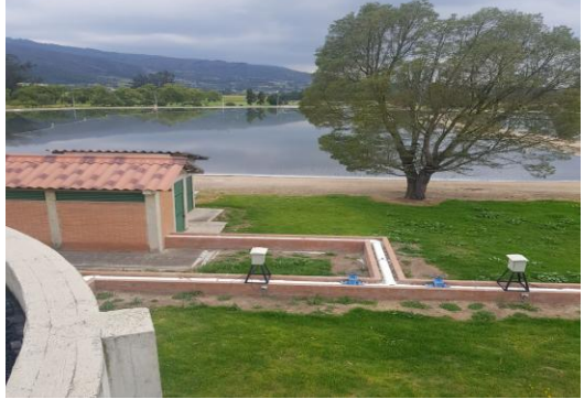
Ilustración 11 Tubería que va a filtros
