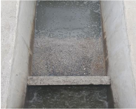
Ilustración 8 Desarenador
