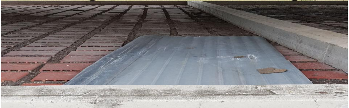
Ilustración 23 Lecho de secado (lodos activos)
