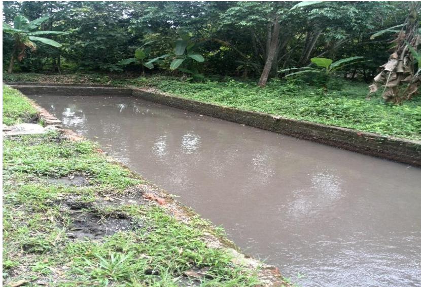
Ilustración 10 Desarenador
