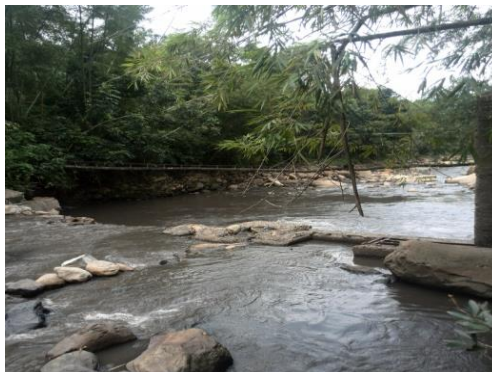
Ilustración 5 Bocatoma de rejilla de fondo
