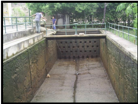
Ilustración 20 Sedimentador
