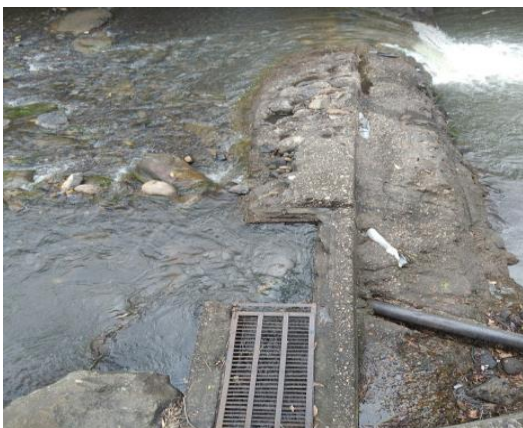
Ilustración 6 Bocatoma de fondo.
