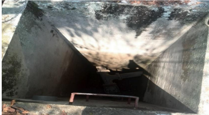
Ilustración 34 Válvulas de acceso
