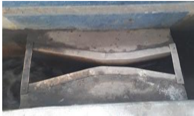
Ilustración 12 Canaleta Parshall
