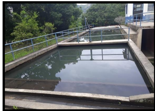
Ilustración 21 Sedimentador en uso
