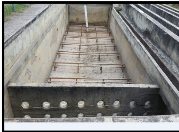
Ilustración 24 Sedimentador sin uso
