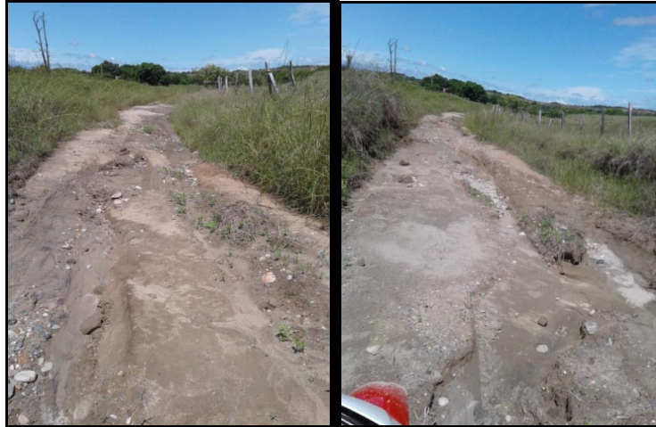
Figura 60. Vía de acceso Doyare centro
