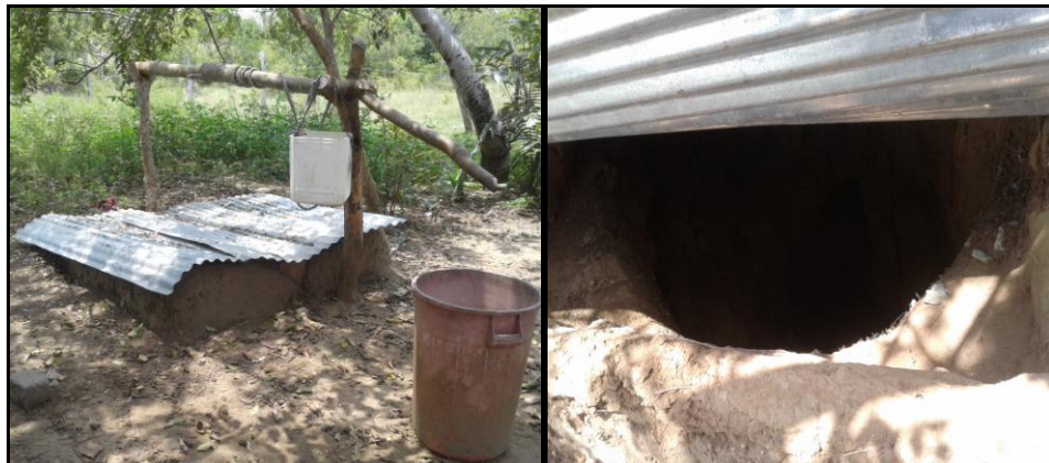
Figura 57. Pozo para extracción de agua
