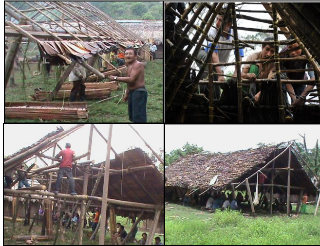
Figura 30. Construcción de vivienda en Maggilangundiwala
