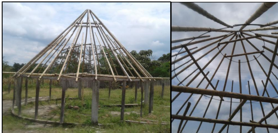
Figura 43. Proceso de construcción caseta de integración social
