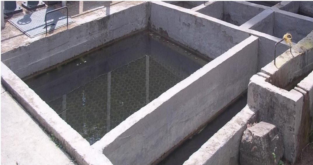
Fotografía 12. Sedimentador
