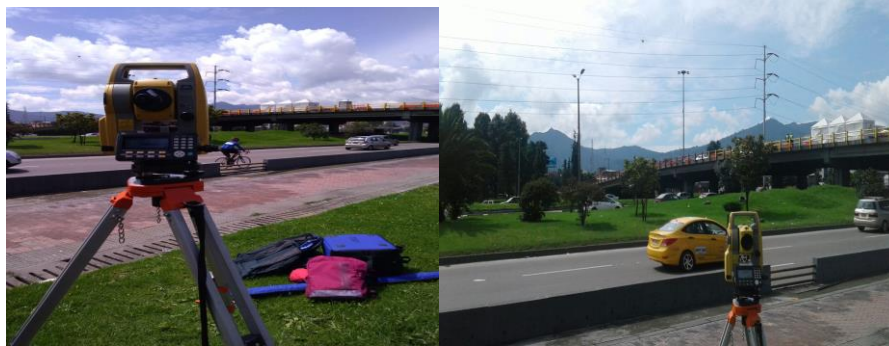
Figura 21 Posicionamiento de la estación TOPCON ES-105
