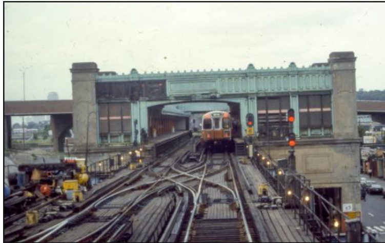
Figura 30. Cruce de sentido en estación terminal.
