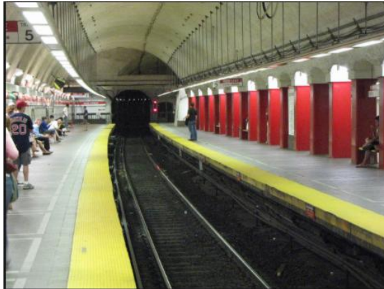
Figura 29. Túnel al inicio estación red roja MBTA
