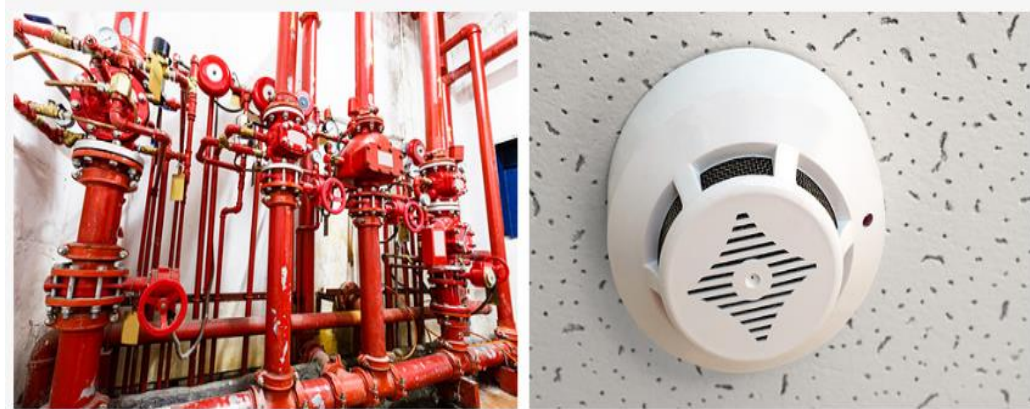
Ilustración 6 RCI (sistemas de redes contra incendio)
