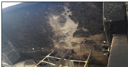
Ilustración 2 Muros pantalla sin recubrimiento
