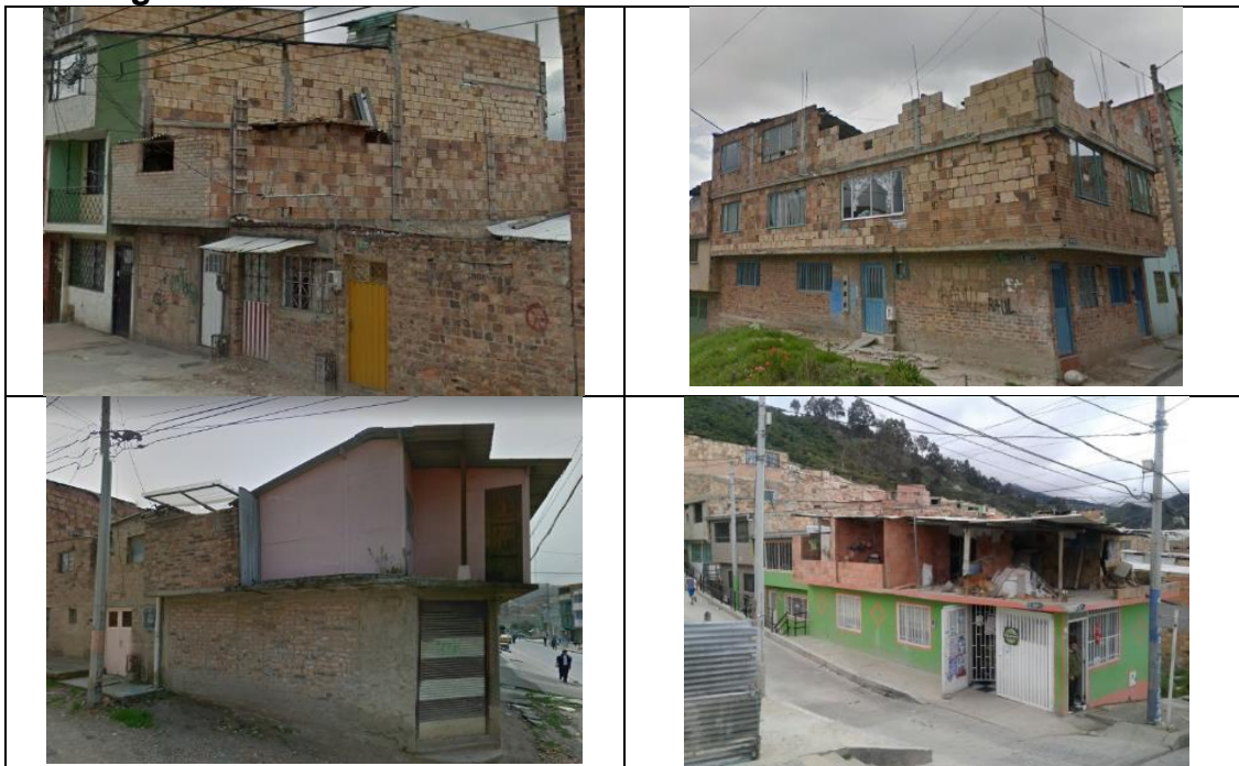
Figura 1 - Estado actual de las viviendas del sector – UPZ Yomasa
