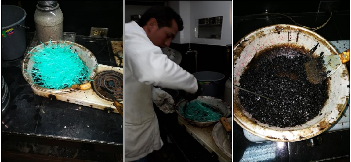
Figura 9 Adición de Polisombra a la mezcla asfáltica y mezclado de materiales
