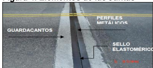
Figura 4. Elementos de las Juntas
