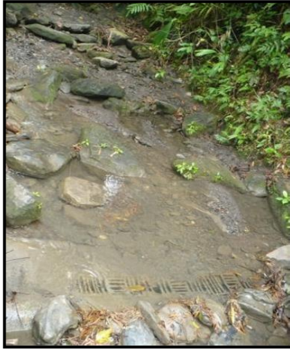
Imagen 14 Bocatoma de fondo – Los Tiestos.
