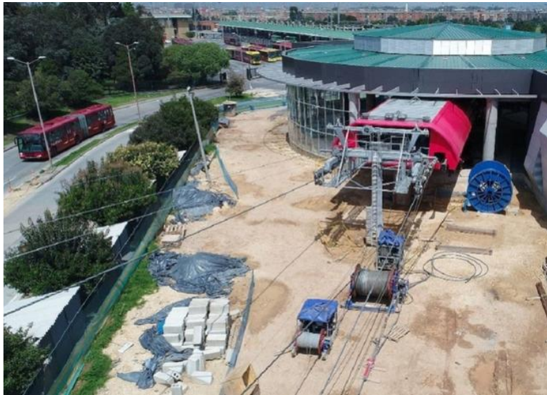
Ilustración 51 Avance de la construcción estación de transferencia Portal Tunal Fuente: (El Espectador 2018) Año: 2018
