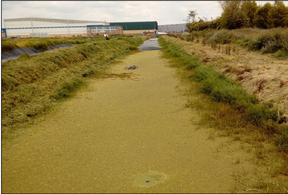
Figura 15. Laguna facultativa con materia vegetal
