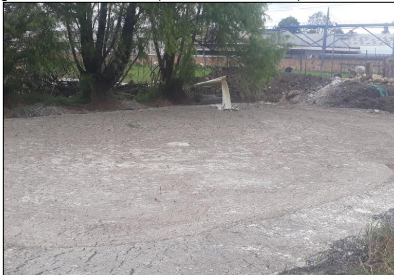
Figura 10. Laguna anaerobia N° 1 (Entrada al sistema)
