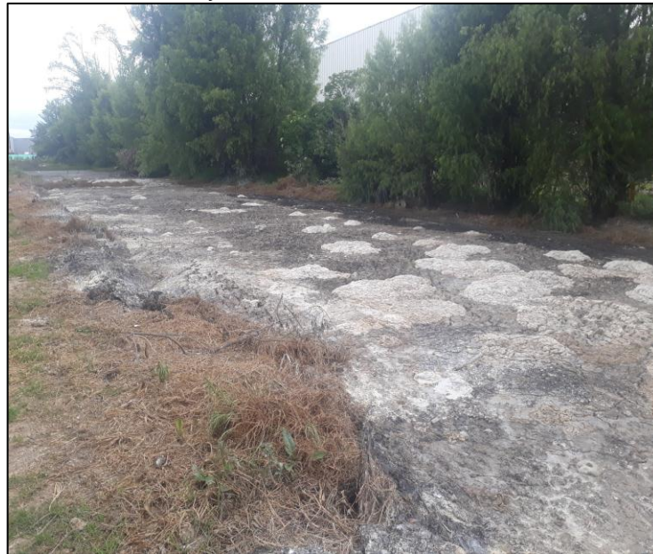
Figura 11. Laguna anaerobia 2 y 3.
