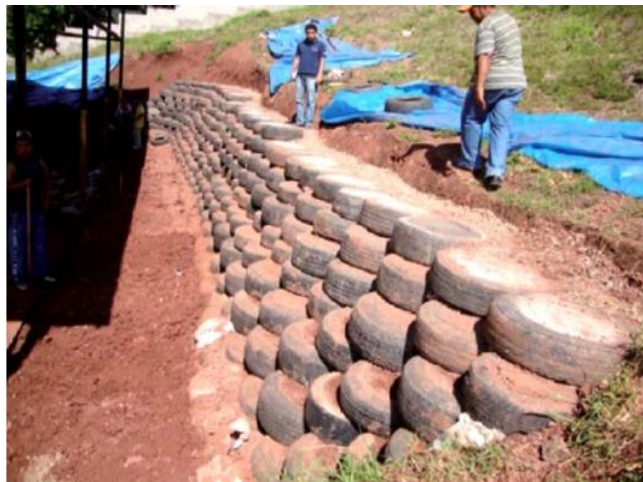
Ilustración 5. Aspecto final obra
