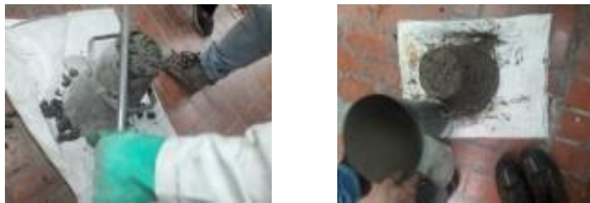
Ilustración 36. Enrase y desencofrado Cono de Abrams
