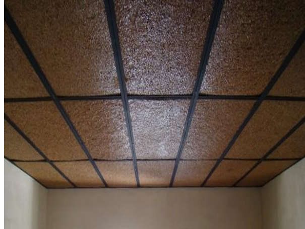
Ilustración 2. Techo con cascaras de Maní
