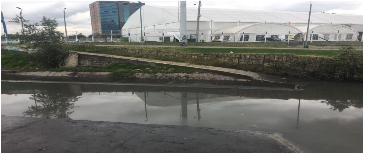
Figura 30. Rampa de acceso de la sección 4.
