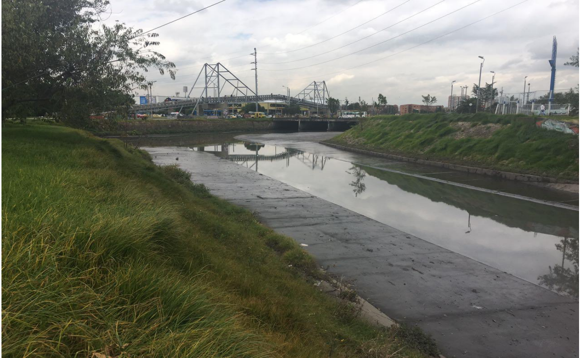
Figura 29. Finalización de la sección 4.
