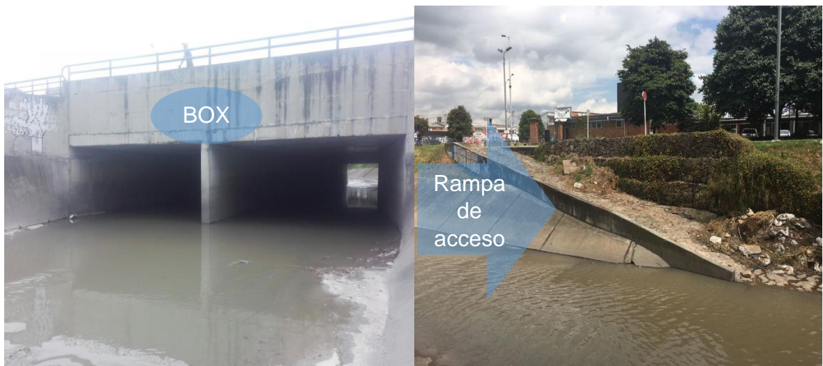
Figura 14. Box y Rampa de acceso.
