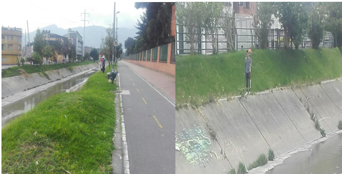
Figura 20. Toma de puntos para la sección 12.
