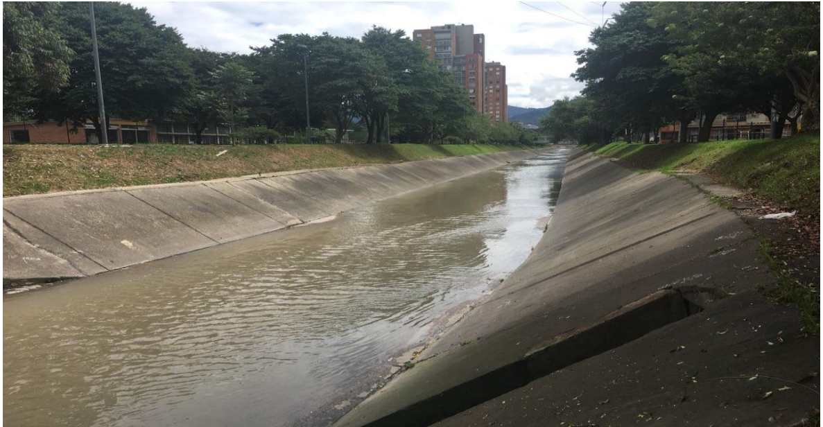
Figura 13. Punto de llegada al BOX y Rampa.
