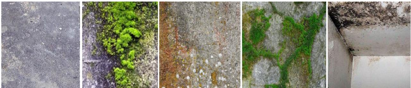
Figura 24. Material biológico presente en estructuras de concreto
