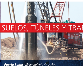
Puerto Bahia - Mejoramiento de suelos.
