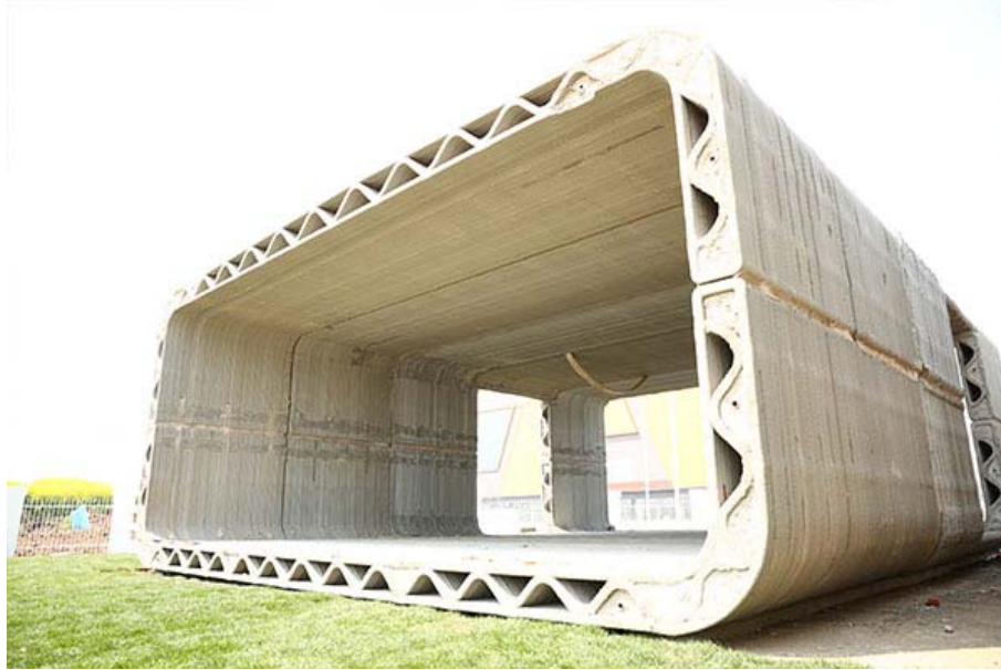
Figura 1- 16 . Cerramiento Estructural En Concreto Vaciado In Situ.
