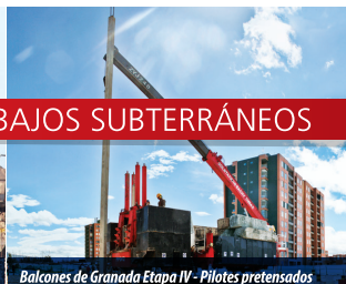
Balcones de Granada Etapa IV - Pilotes pretensados
