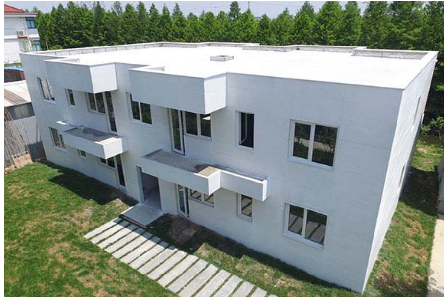
Figura 1- 15. Vivienda Impresa Por Winsun.
