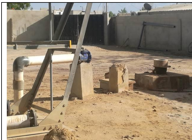
Foto 5: Pozo profundo construido por el Servicio Geológico Colombiano, caudal de diseño 80 l/s.
