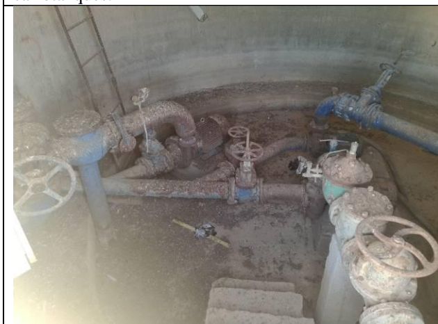
Foto 11: Estación de bombeo para el llenado del tanque elevado.
