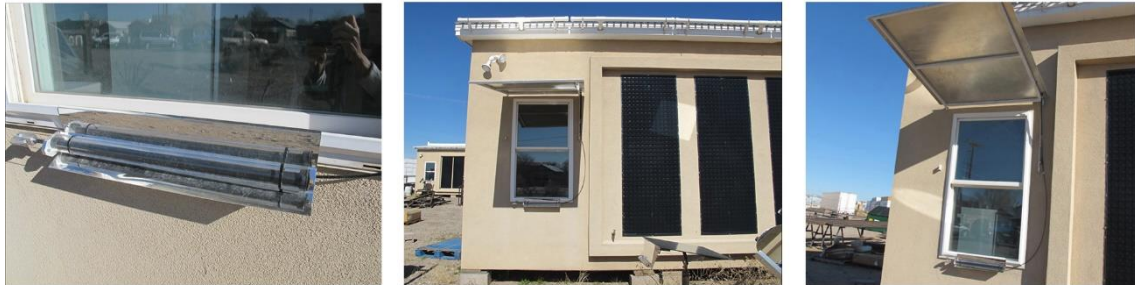
Figura 7 - Controle solar através de um material com memória de forma – Wax Actuator with Sun Shade. Fonte: [11].
