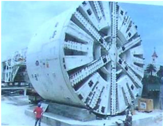
Fig. 31 - A tuneladora utilizada na zona do Cais do Sodré (F.I. - M a F a Rollo, Um Metro e Uma Cidade , vol. 2, p. 251)
