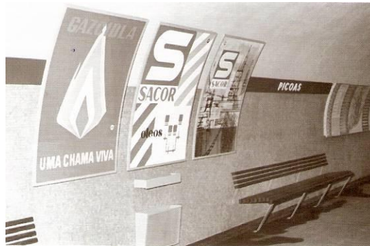
Fig. 36 - Estação de metro da 1ª fase: mobiliário dos cais de embarque (F.I. - Mª Fª Rollo, Um Metro e Uma Cidade , vol. 3, p. 96)
