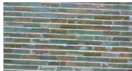
Fig. 38 - Pormenor do revestimento exterior da Casa da Moeda
