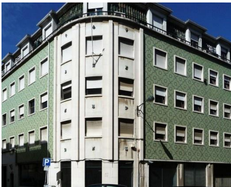
Fig. 42 - Almada Negreiros, revestimento em azulejo, Lisboa (F.I. - www.vitruvius.com.br/revistas/read/arquitextos/13.148/4490 , cons. 20/11/2013)
