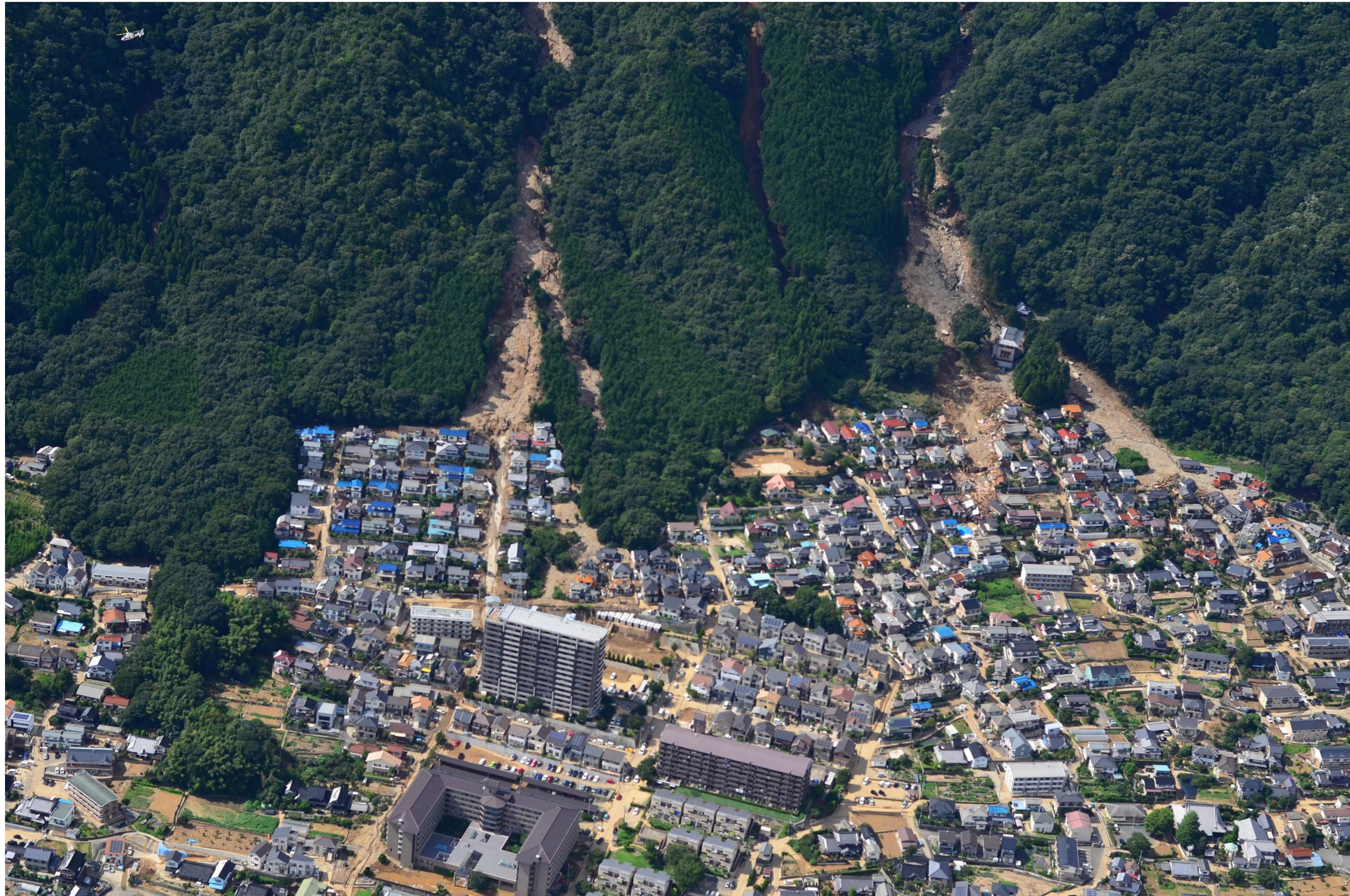
2014年8月に広島で発生した土石流（航空写真提供：株式会社パスコ）
