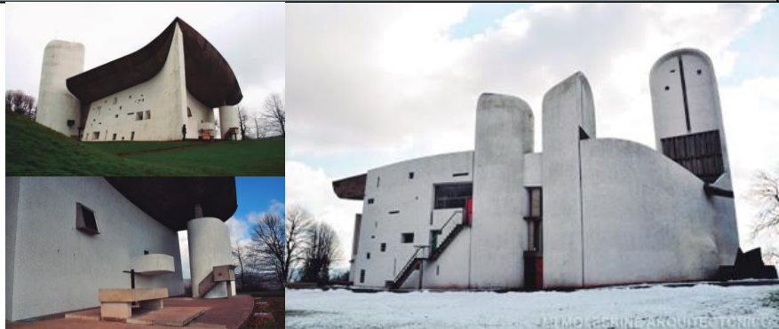
Imagen 36: Fachada Este Capilla de Notre Dame Fuente: www.arquibox.com/es/index
