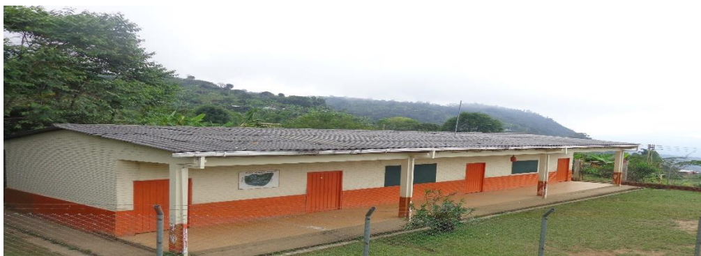
Fotografía Escuela sede Piedras.
