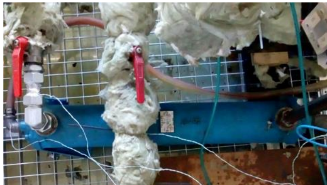
Figura 3.3: Permutador de calor utilizado na instalação experimental.
