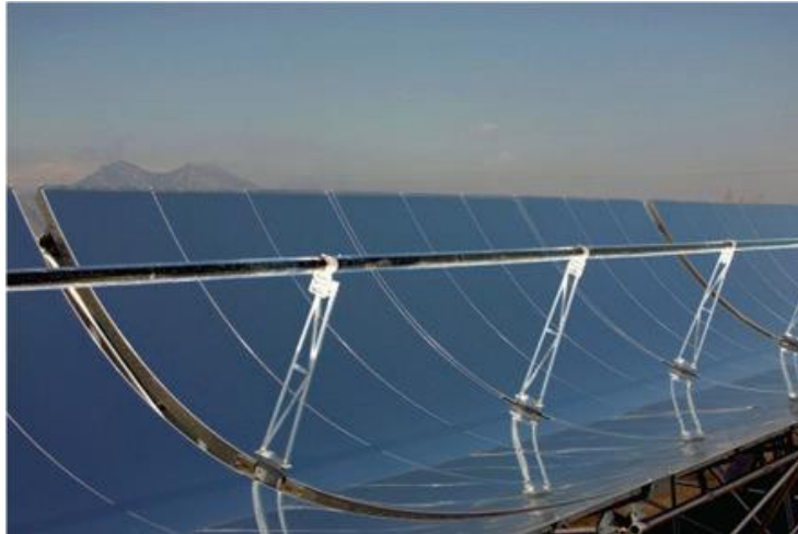
Figura 2.1: Coletor solar térmico, com concentrador da radiação solar (espelhos refletores parabólicos) e tubo recetor (onde circula o fluido de transferência de calor) (Fleischer, 2015).
