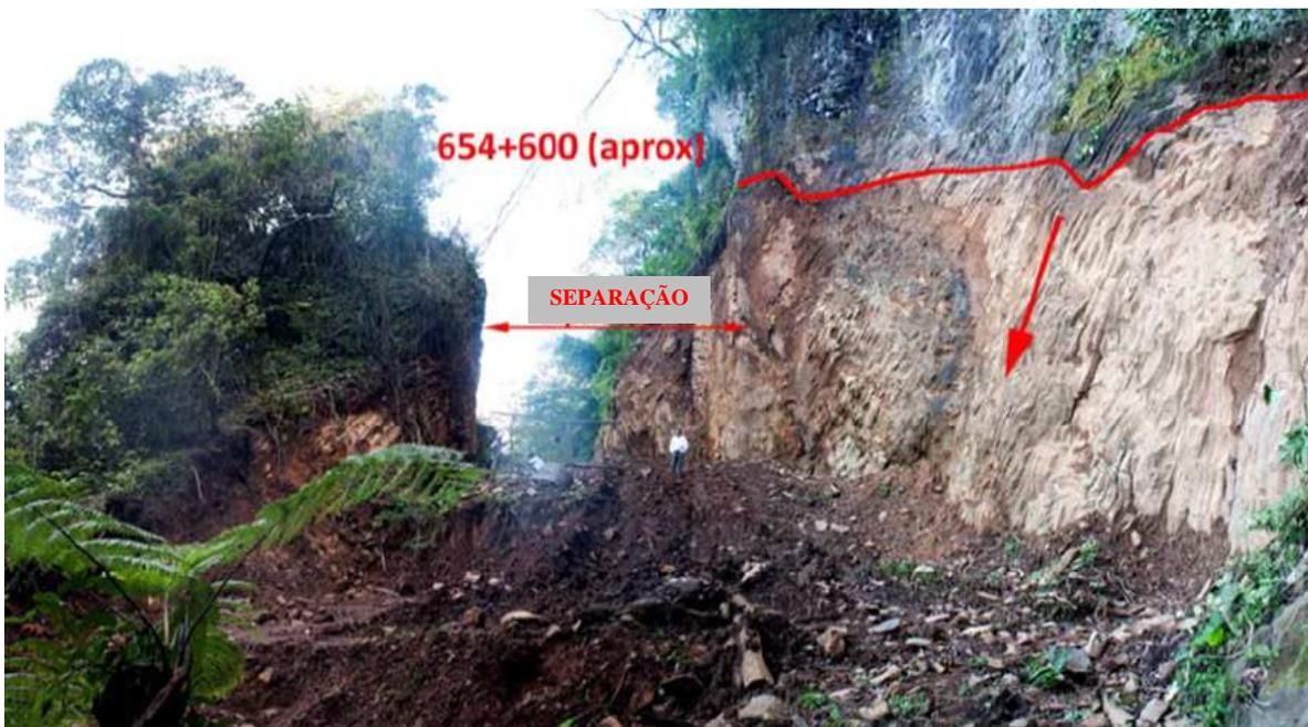
Figura 2.31 – Zona do colapso à superfície vista de México para Tuxpan. A linha vermelha indica a fronteira da separação dos basaltos. Note-se a mudança de coloração dos basaltos (CONSULTEC, 2013a).
