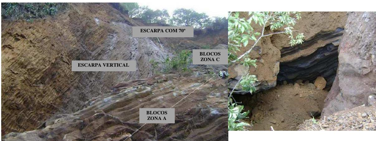
Figura 2.24 – Túnel Xicotepec I – Portal México. (à esquerda) Superfícies do deslizamento alteradas (diferença de cor) que indicam a existência de fracturação vertical antiga. (à direita) Cavidade existente na base do bloco principal “A”.
