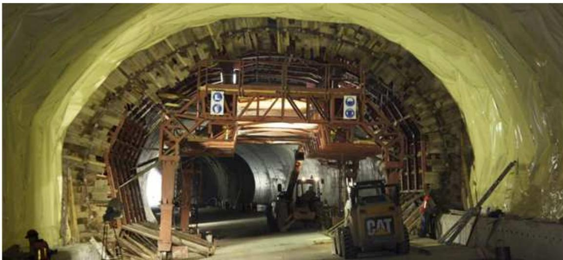
Figura 2.19 – Túnel Zoquital – Zona de avanço da betonagem do revestimento definitivo não armado.
