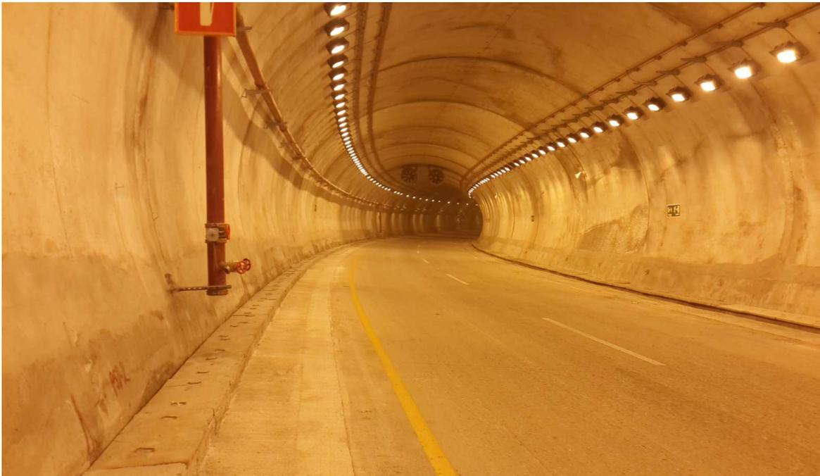
Figura 5.8 – Revestimento definitivo não armado e instalações terminadas.
