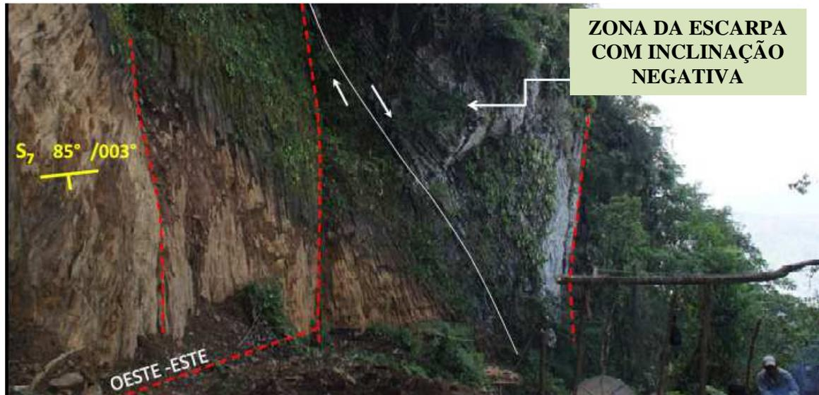
Figura 3.3 – Escarpe principal formado pelo colapso. As linhas vermelhas descontínuas representam traços da falha S7 de direção 85°/003° da Família 2 (CONSULTEC, 2013a).
