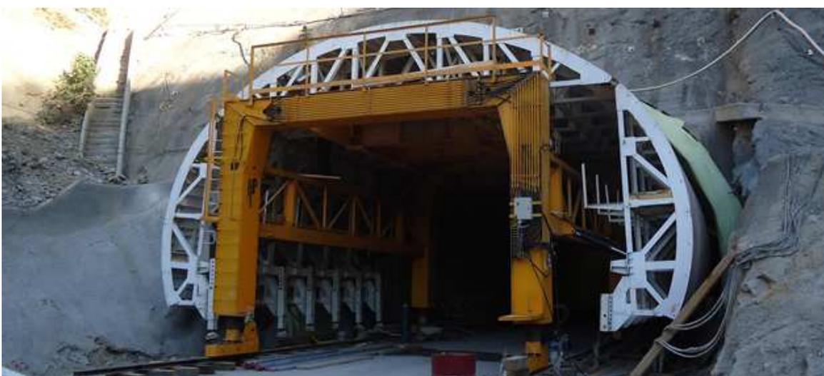
Figura 2.20 – Túnel Huauchinango – Cimbre utilizado para betonagem do revestimento definitivo não armado.
