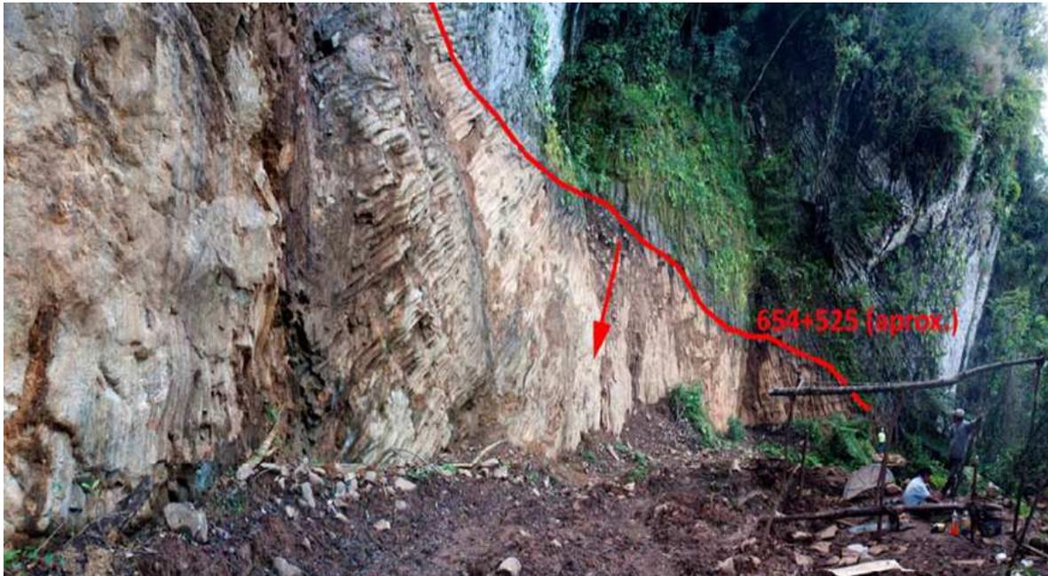
Figura 2.30 – Zona do colapso à superfície vista de Tuxpan para México. A linha vermelha indica a fronteira da separação entre os basaltos intemperizados (cinzentos) e os basaltos que ficaram descobertos com o colapso (castanhos) (CONSULTEC, 2013a).
