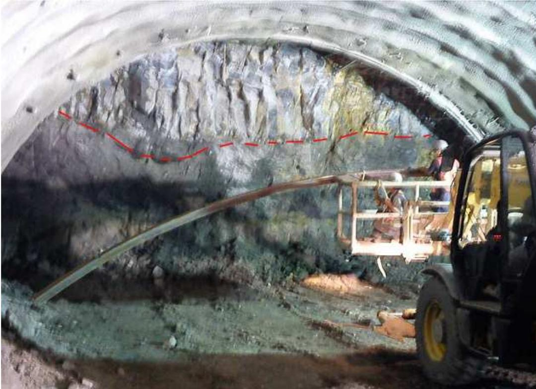
Figura 3.1 – Frente de escavação do Túnel Esquerdo (k654+573) no qual se aprecia o contato entre os basaltos colunares e o estrato argiloso.
