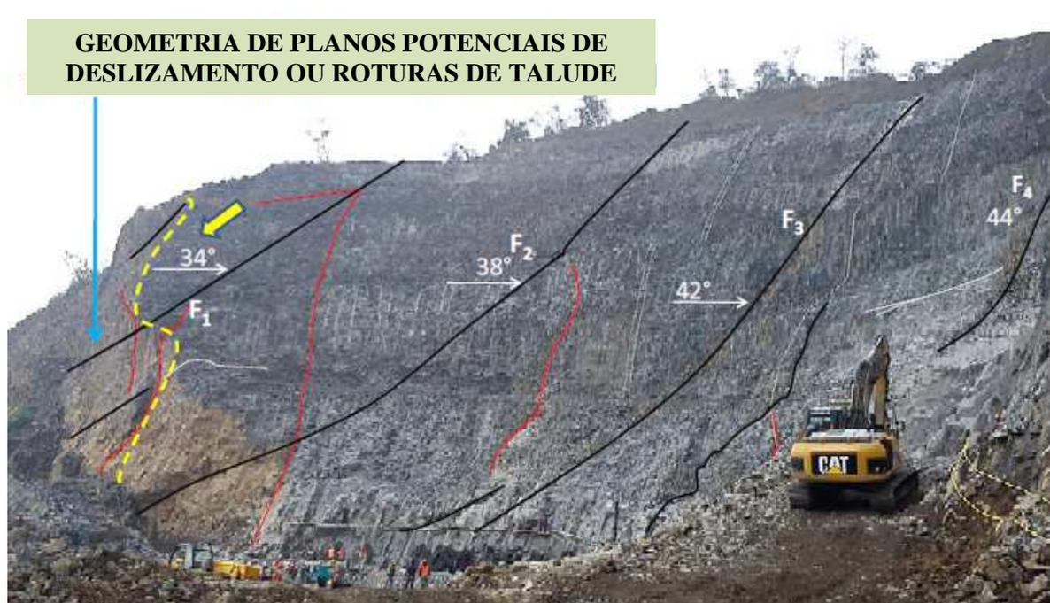
Figura 3.5 – Vista do Portal México onde ressalta a geometria das fracturas e falhas da Família 1 com respeito à direção do corte do talude (CONSULTEC, 2013a).
