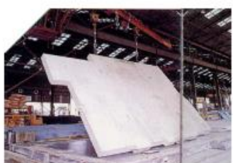
3. Desmolde y almacenaje de los paneles
