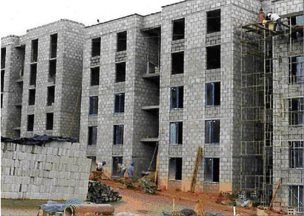
Figura 20. Conjunto habitacional VIS desarrollado con mampostería reforzada en bloque de concreto. Fuente: http://materialesdeconstruccion.blogspot.com.ar/2012/10/mamposteria-estructural.html
