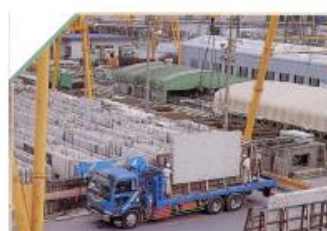
4. Transporte e izaje de los paneles
