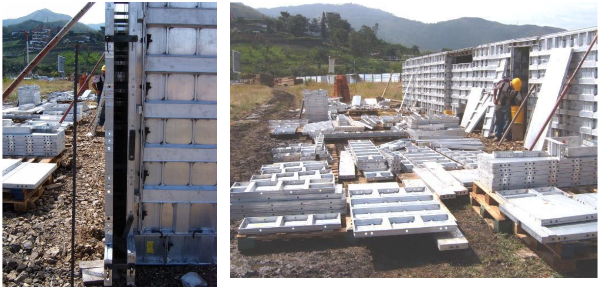
Figura 30. Detalle y vista exterior de la formaleta armada de un apartamento tipo VIS utilizando el sistema constructivo Con-tech. Fuente: Elaboración propia, proyecto Patios de la Flora, Cali-Colombia.
