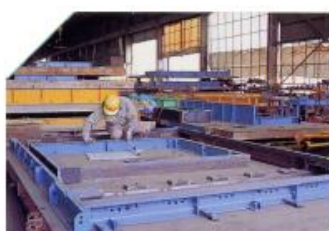
1. Adecuación de formaletas y colocación de refuerzo
