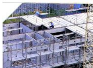
Figura 29. Proceso constructivo con el sistema de grandes paneles. Fuente: Echeverry Campos & MetroVivienda, (2000).
