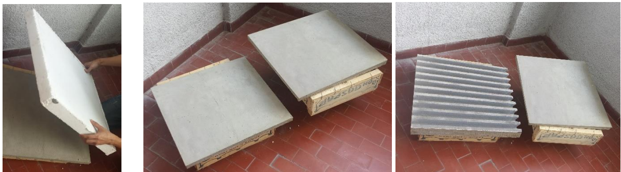
Figura 74. Desencofrado y resultado final de las placas de concreto. Fuente: Elaboración propia.
