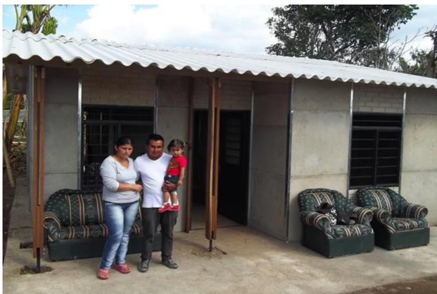
Figura 27. Aspecto exterior de una VIS construida con el sistema constructivo Servivienda. Fuente: http://www.jesuitas.org.co/noticia.html?noticia_id=479
