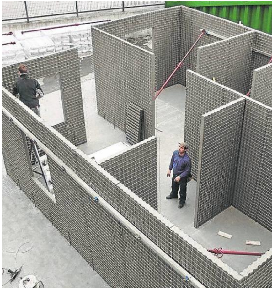
Figura 24. Proceso constructivo de una vivienda utilizando el sistema constructivo 3D panel. Fuente: http://noticias.arq.com.mx/Detalles/17370.html#.WR9T1Wg1-M8
