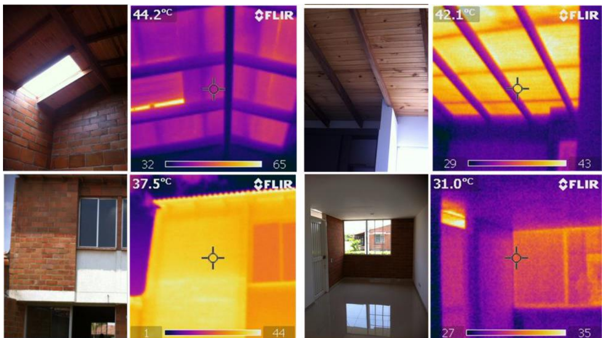
Figura 38. Termografías interiores de una VIS con envoltente de bloques de arcilla. Fuente: (Barona, 2016)
