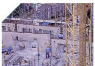
Figura 29. Proceso constructivo con el sistema de grandes paneles. Fuente: Echeverry Campos & MetroVivienda, (2000).
