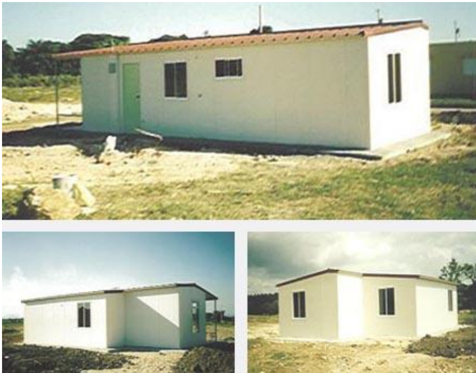
Figura 28. Soluciones de VIS de 36m 2 y 56m 2 desarrolladas con el sistema constructivo Metecno. Fuente: http://www.metecnocolombia.com/viviendas/montajecasa.html
