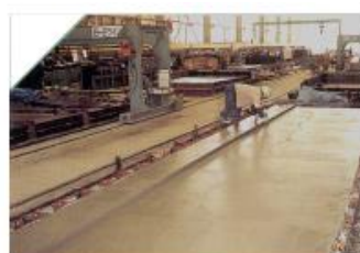
2. Colocación y afinado del concreto
