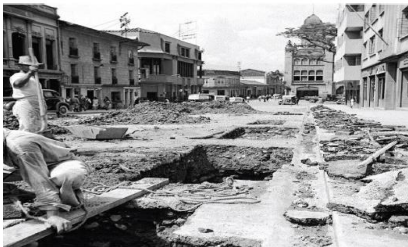
Figura 6. Construcción del alcantarillado de Medellín en la década de 1940. Fuente: (Inicios del alcantarillado de Medellín 1920-1955, 21)
