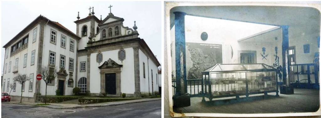
Figura 8. Fotografias da fachada sul do seminário de Viana do Castelo, 2013 (esq.); e da sala do museu (dir.), s/d. APPCSSp
